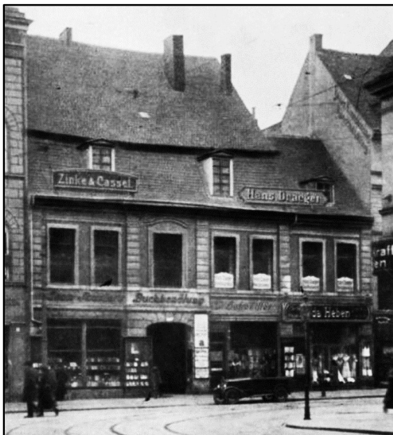
Abb. 14: Haus Potsdam (vormals Hotel) nun Buchhandlung in der Mönchenstraße 12/13 (eigentlich wie ersichtlich zwei Gebäude). Die Gebäude existieren heute nicht mehr. (Quelle: www.sedina.pl ).
